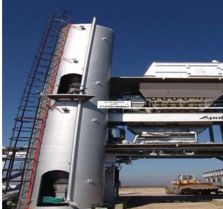
Fig. Mineral filler unit
